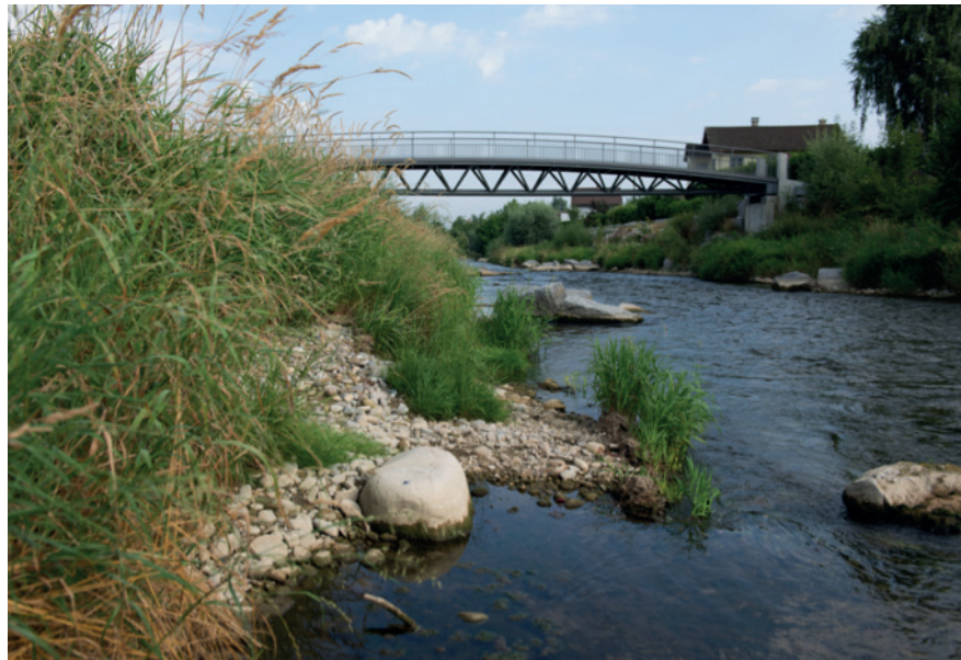
Abb. 12 Wiggerpark: Wiggerrenaturierung, Hochwasserschutz Wigger, Teilprojekt Brittnau (Quelle: Verein AareLand).
