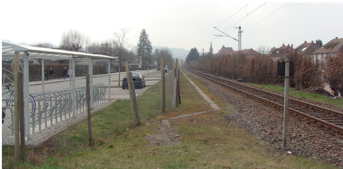
Bike-and-Ride und Park-and-Ride Anlage Haltestelle Schopfheim Schlattholz
