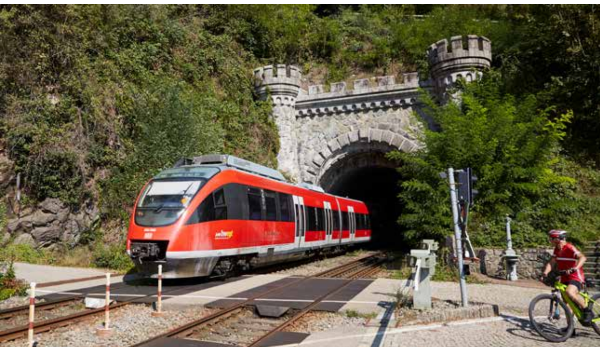
Westportal des Rappenstein-Tunnels
