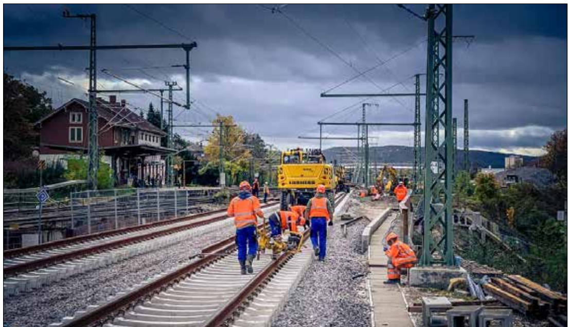
Arbeiten an der Strecke Karlsruhe – Basel
