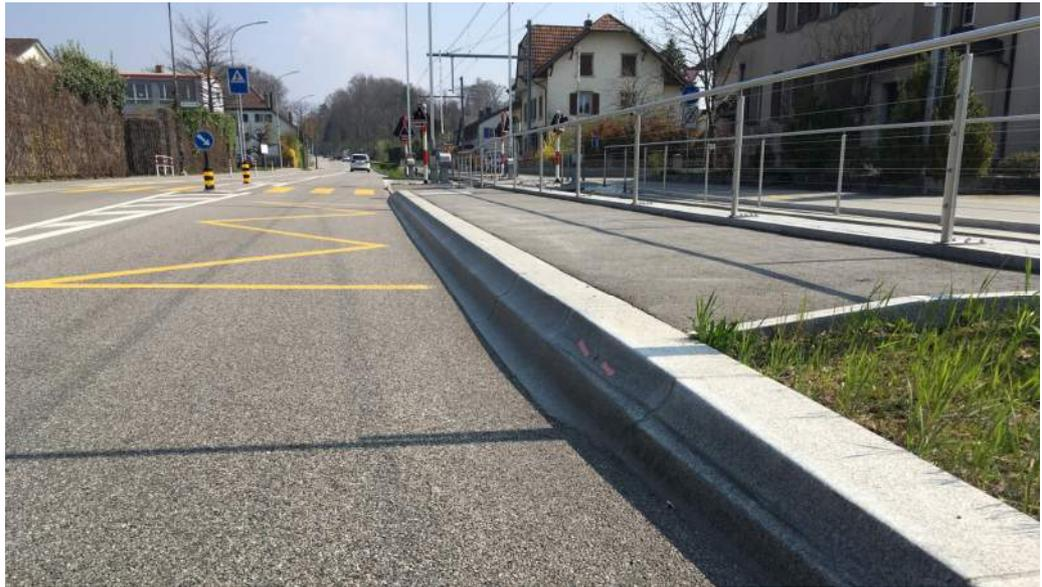
Abbildung 5: Beispiel einer sanierten Haltekante mit Kantenhöhe 22 cm.
