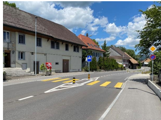
Abbildung 23: Zu schmaler Aufstellbereich bei Fussgängerschutzinsel in Gunzgen; Aufnahme Begehung Mai 2024
