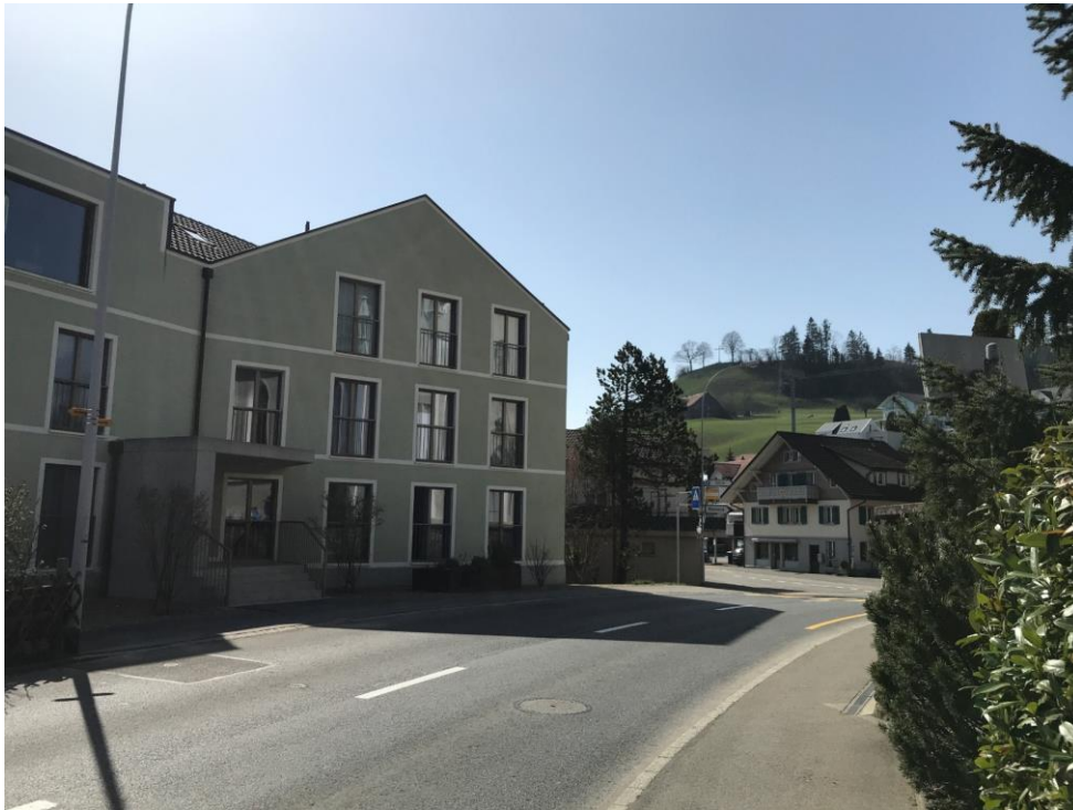
Abbildung 60 Beispiel Wohnnutzung mit architektonischem Bezug zur Strasse, Hergiswil LU. Bild: VdW
