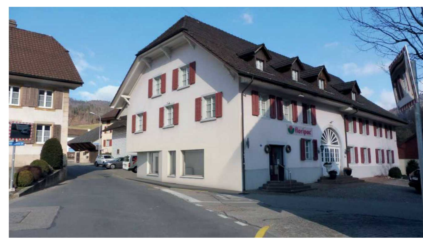
Ansicht Fassade von Süden nach Norden
