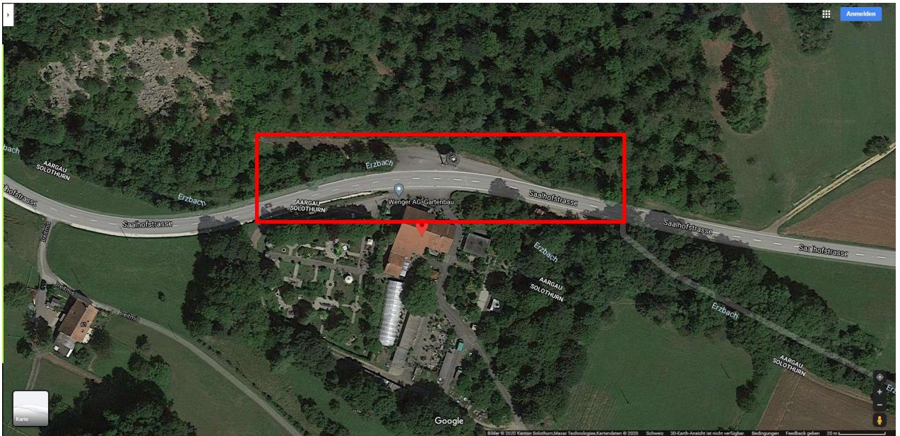
Abbildung: Luftbild Saalhofstrasse 41 (im Bereich Gärtnerei Wenger mit Situation des Baustellenperimeters).
