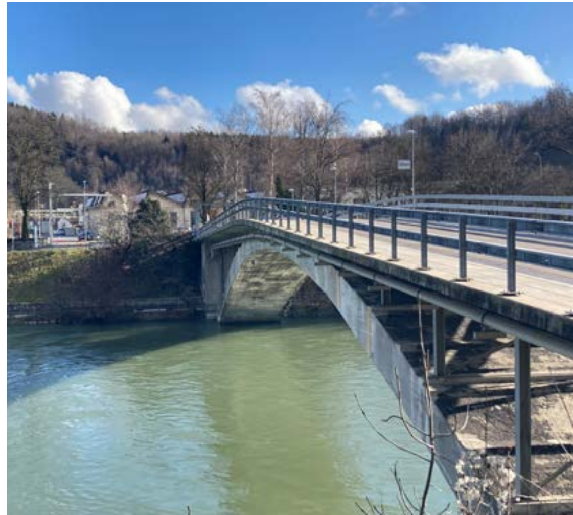
Die Fahrbahnplatte mit der konzentrierten Krümmung im Scheitelpunkt.
