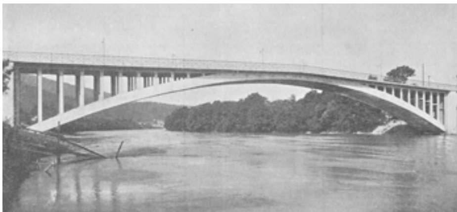
Die historische Trimbacherbrücke mit vierreihigen Betonstützen (oben) und Situation über die Aare (links). (Bild aus Froté, E., «Pont en béton armé sur l'Aar, à Olten», Bulletin technique de la Suisse romande, Band 40, Heft 22, 25.11.1914, S.249-255.)
