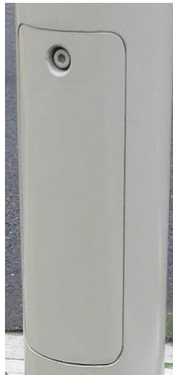
Abbildung 3: Beispiel Masttürchen mit Innensechskant-Verschluss M8
