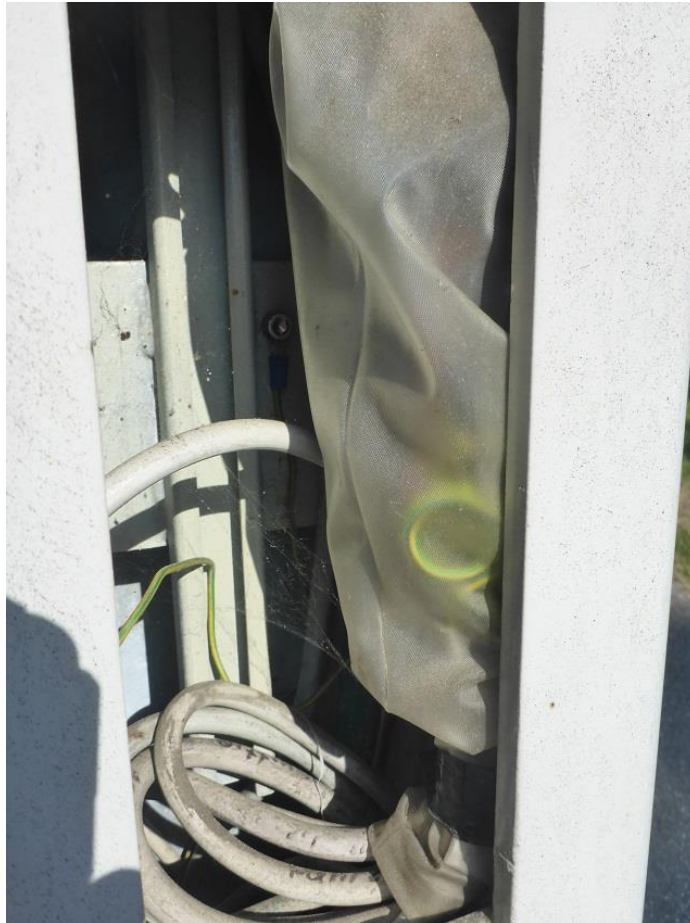
Abbildung 6: Ansicht auf die mit einem Plastiksack geschützten Mastklemmen hinter dem Masttürchen
