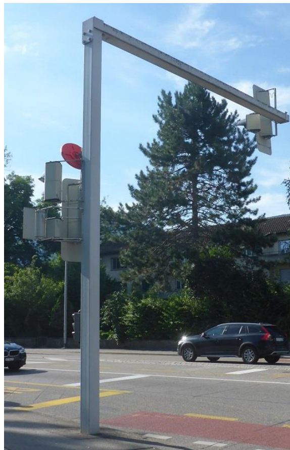
Abbildung 4: Vorder- und Rückansicht eines Winkelmastes
