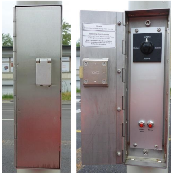
Abbildung 9: Handsteuerung mit geschlossenem und offenem Türchen
