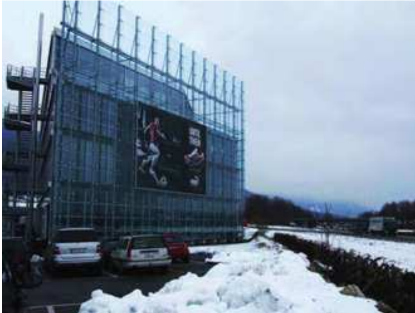
Bauliche Massnahme: vorgehängte Glasfassade
