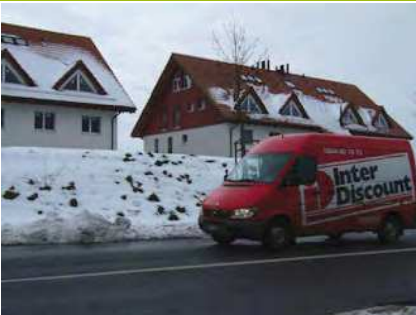
Bauliche Massnahme: Lärmschutzdamm
