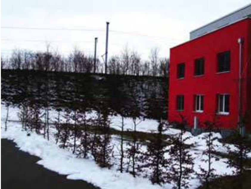
Bauliche Massnahme: Lärmschutzdamm
