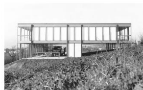
Stahlterrassen, Referenz: Haus Buchli, Fritz Höfer
