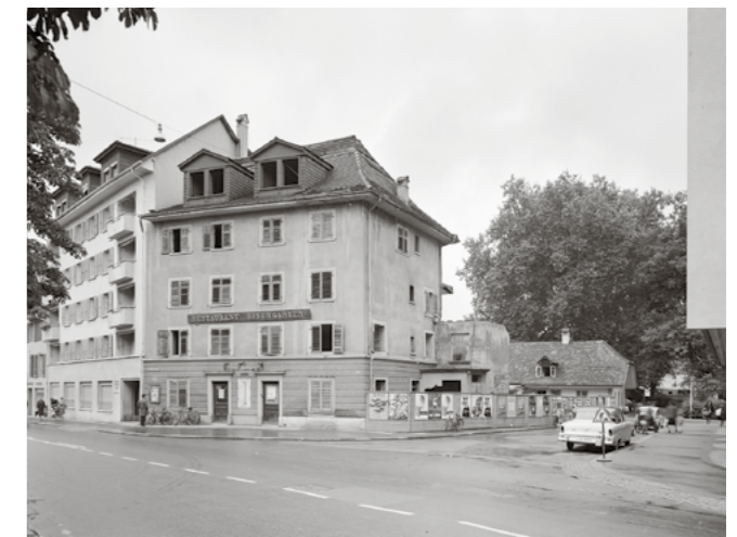
09/010 Abbruch des ehemaligen Restaurants Rosengarten ab 1962
