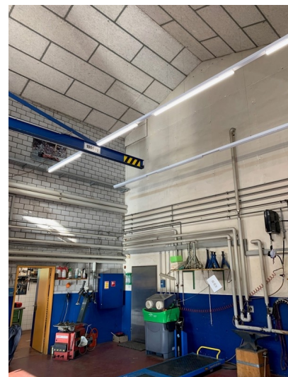
neue LED-Beleuchtung Bild Hochbauamt
