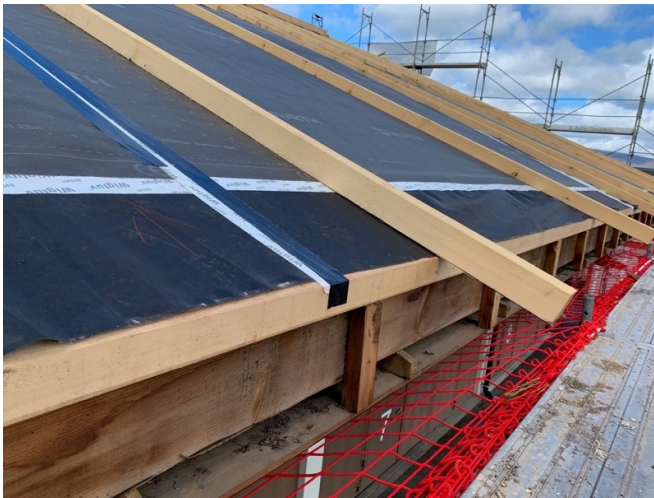
neuer Dachaufbau Bild Hochbauamt
