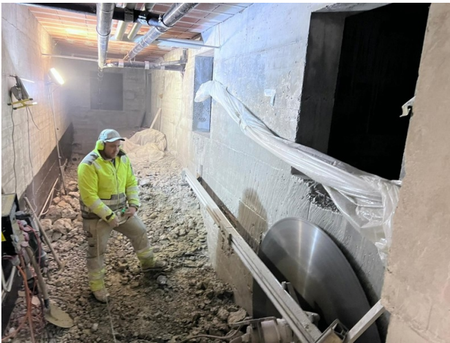
Rückbau Fels Bild Hochbauamt
