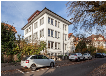
Fassadenansicht Bild Iff Architekt GmbH
