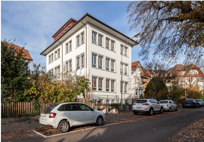
Fassadenansicht Bild Iff Architekt GmbH
