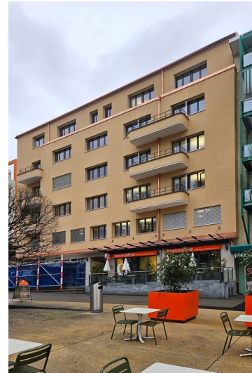
Südwestansicht Bild Bigolin + Crivelli Architekten AG
