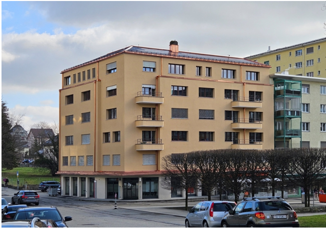
Gebäudeansicht Bild Bigolin + Crivelli Architekten AG
