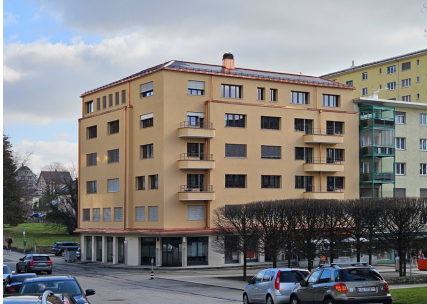
Gebäudeansicht Bild Bigolin + Crivelli Architekten AG
