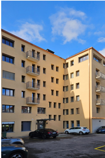
Ostansicht Bild Bigolin + Crivelli Architekten AG
