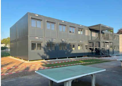
Schulraumprovisorien Bild Hochbauamt
