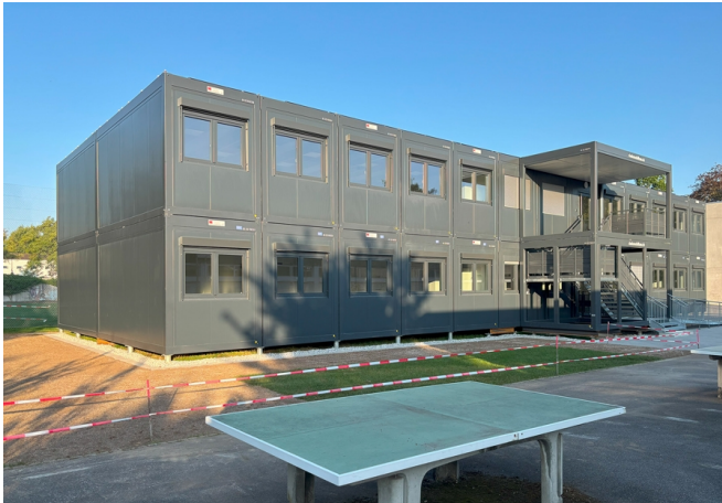
Schulraumprovisorien Bild Hochbauamt
