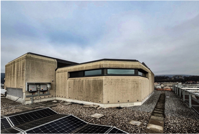
Attika Bild RBA Architekten GmbH
