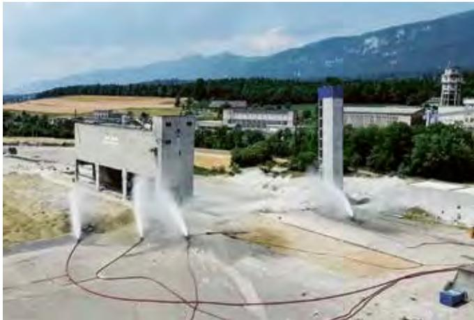
Am 17. Juli 2015 wurden auf dem Borregaard-Areal in Luterbach das 34 Meter hohe Hackschnitzelsilo und die etwa 40 Meter hohe Eindampfanlage (Liffturm) gesprengt. Diese Sprengung war notwendig, um die Vorbereitungsarbeiten für die geplanten Bauarbeiten zur Ansiedlung der Firma Biogen vorantreiben zu können.
