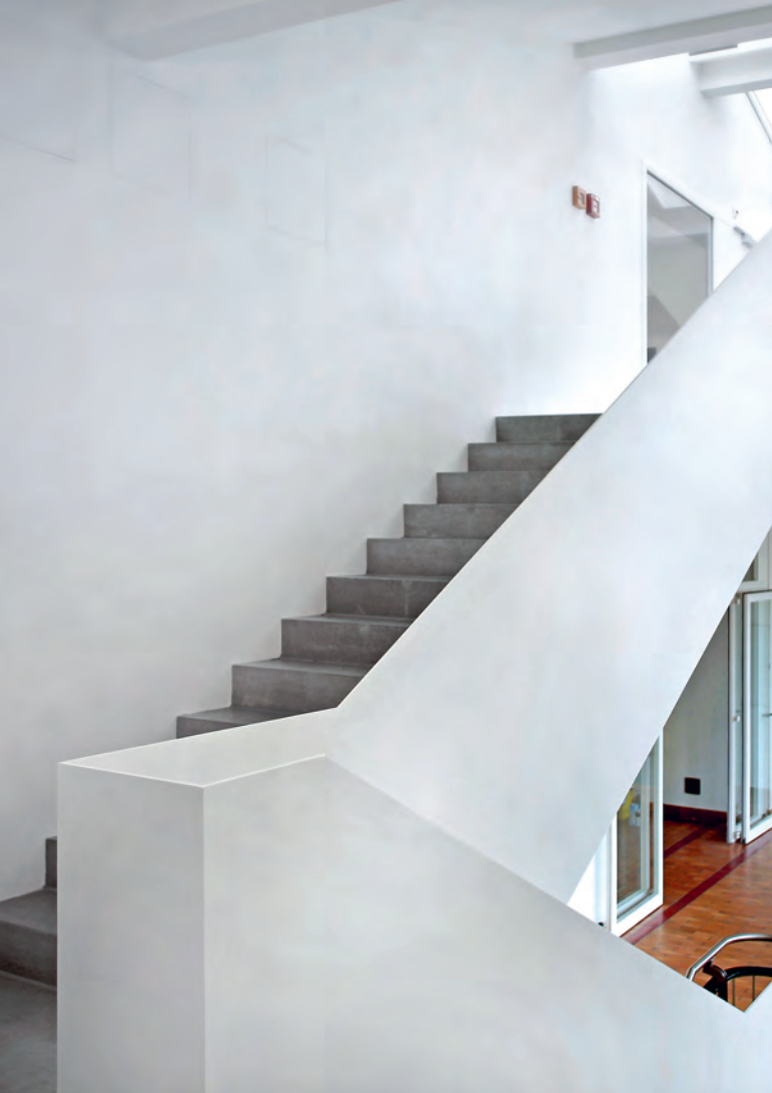
Erweiterung Treppenhaus Süd.
