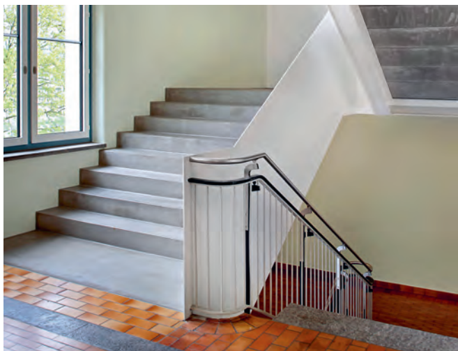
Erweiterung Treppenhaus Nord.
