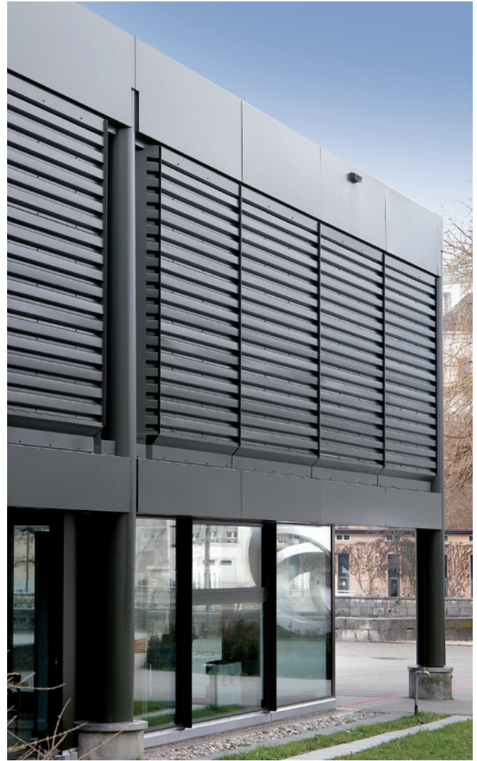
Stirnfassaden Ost und West
