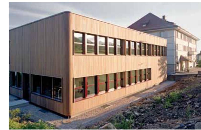
Das Schulgebäude vor der Renovation und mit der neuen Fassade.
