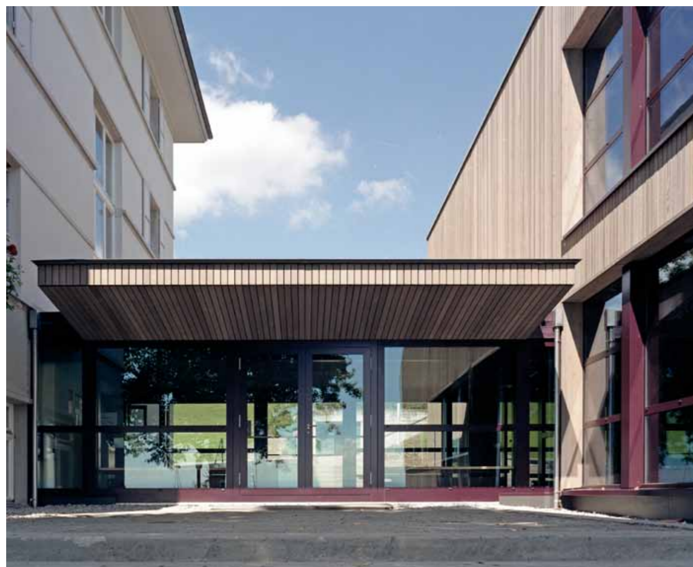
Oben: Empfang mit Theke und Schaukasten. Unten: Windfang und Verbindungsgang.
