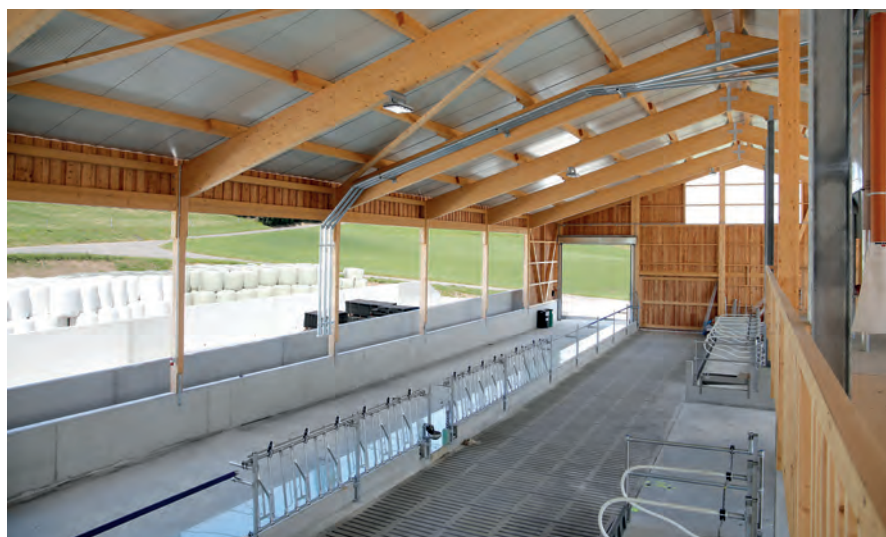
Fressgang und Futtertenne
