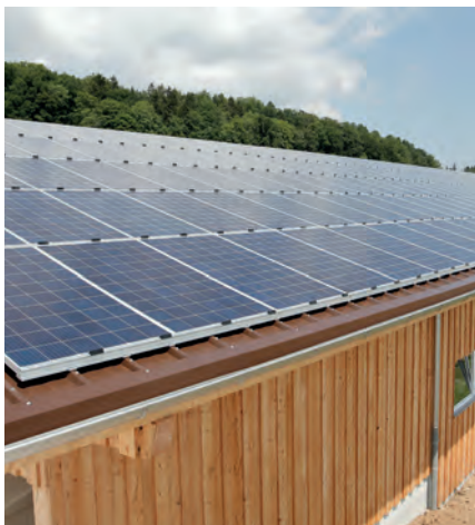
Photovoltaikanlage auf Remise
