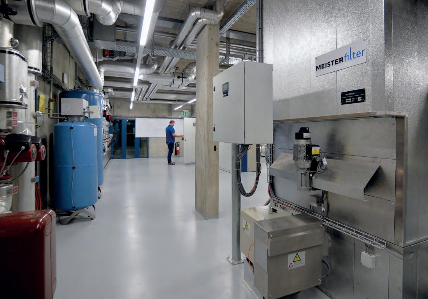
Expansion und Elektrofilter
