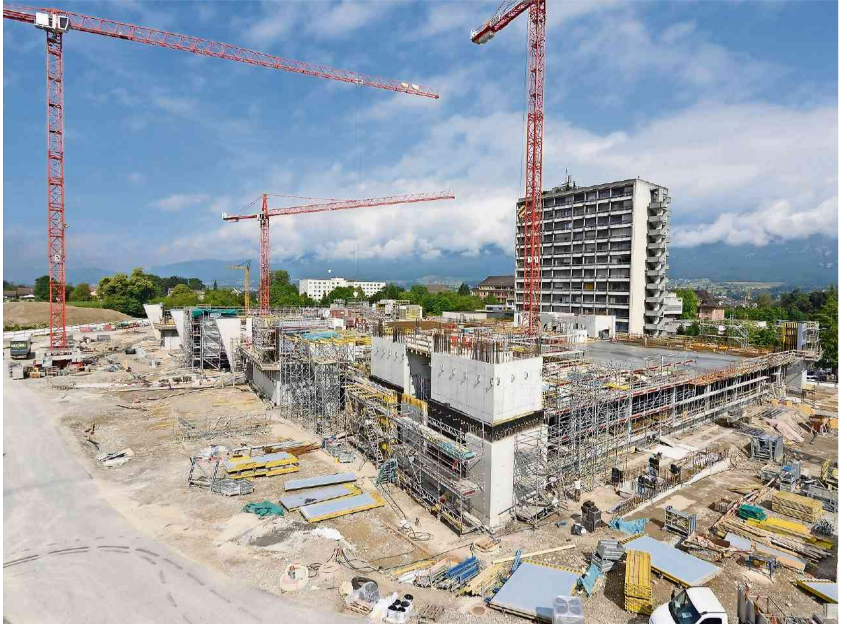
Der Rohbau nimmt Gestalt an: Das Bettenhaus (im Vordergrund) und der Flachbau (gegen Westen) mit den Behandlungsräumen.
