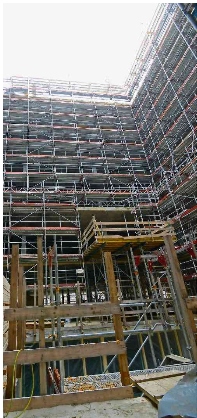
Der grosse Lichthof im Bettenhaus.
