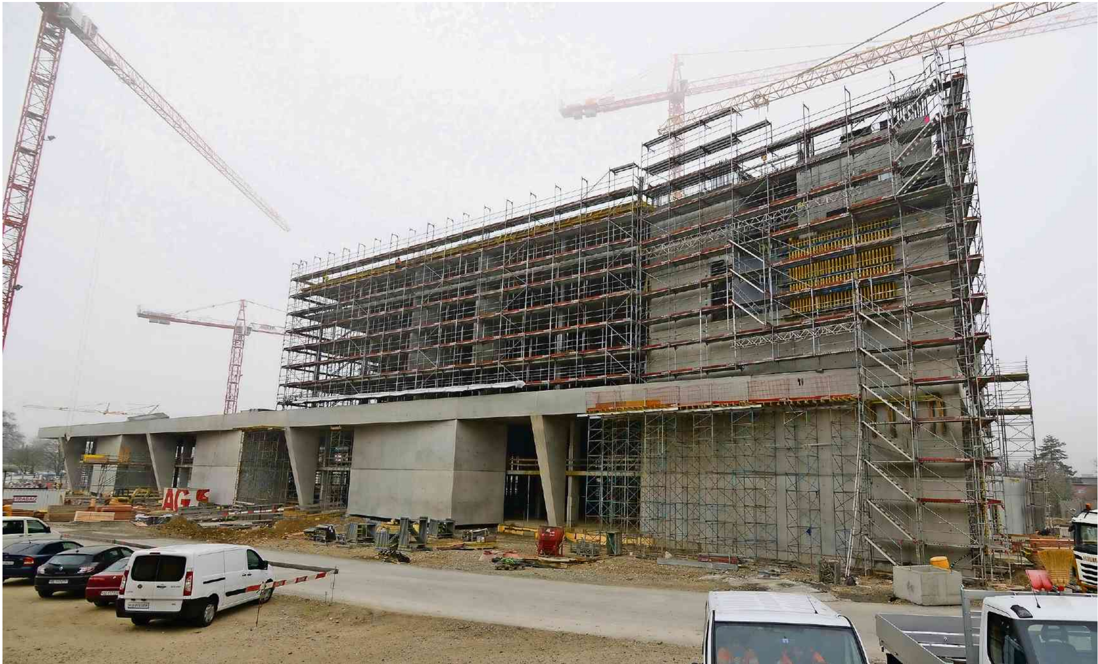
Die Südseite des neuen Bürgerspitals: Im Rohbau fertiggestellt ist der zweigeschossige Flachbau (links). Mit dem Bettenhaus, das sieben Stockwerke zählen wird, ist es im Mai 2017 so weit.
