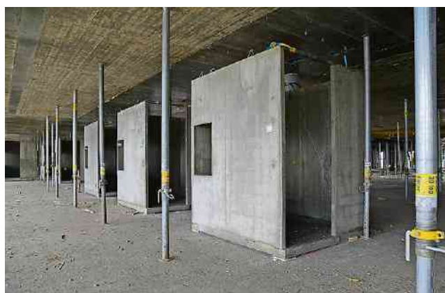
Die Nasszellen der Bettenzimmer im 4. Stock sind aufgestellt.
