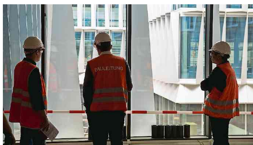
Im Innenhof sind die «Brise Soleil» vor den Fenstern bereits montiert.
