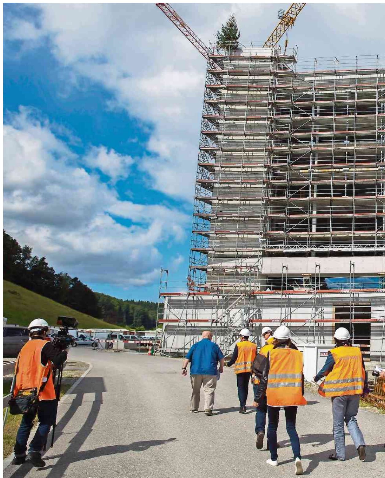
Für Besucher gibt es auf der Grossbaustelle viel zu beobachten: In luftiger Höhe sind Arbeiter mit den letzten Dachaufbauten beschäftigt.
