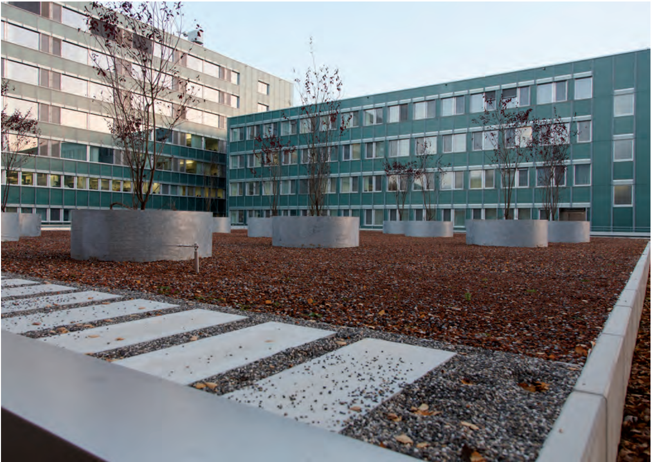
Nordfassade mit Dachgestaltung Ambulanzgaragen
