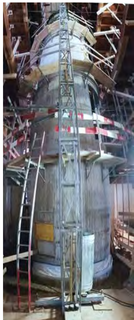
Lift- und Treppenturm im Bau
