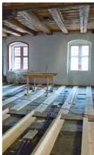
Bodenschiftung mit Installationen
