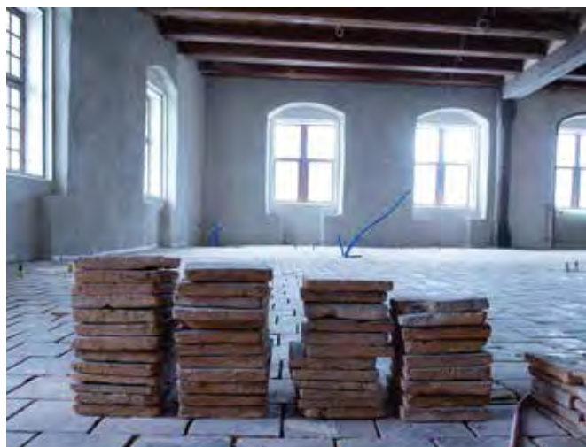
Wiederverlegung der historischen Platten
