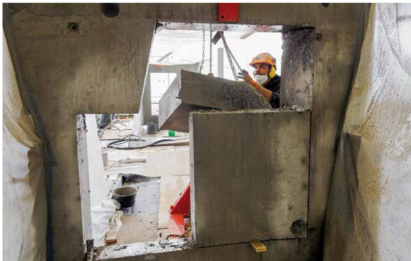
Bauwerkstrenner schaffen Öffnungen, Durchbrüche und Aussparungen.
