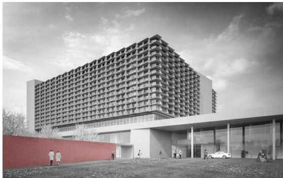
Ansicht Interventionsperimeter Aussenwand
