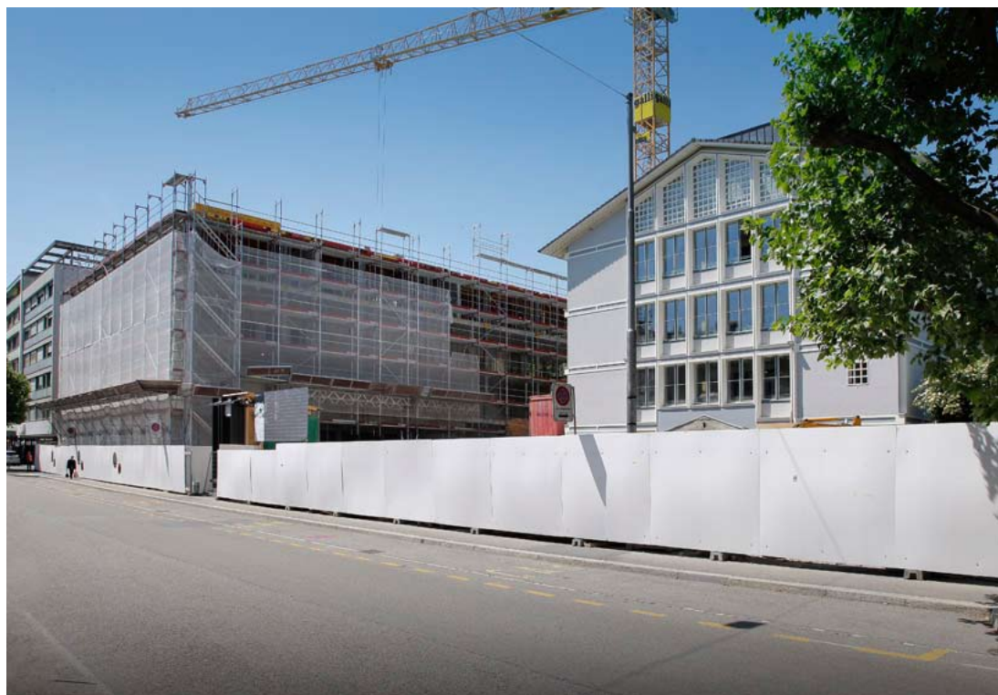
Mit dem Neubau entsteht in Solothurn ein richtiger Campus. Wie der Neubau täglich wächst, können Sie im Internet live mitverfolgen. Klicken Sie hier
