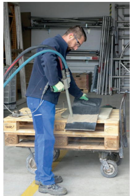
Die Kälte macht es möglich: Zwei-Komponenten-Kleber wird problemlos von einer Schiefertafel entfernt.
