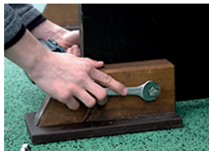
Jede Schraube wird zweimal kontrolliert – und es gibt viele Schrauben am Pumptrack.
