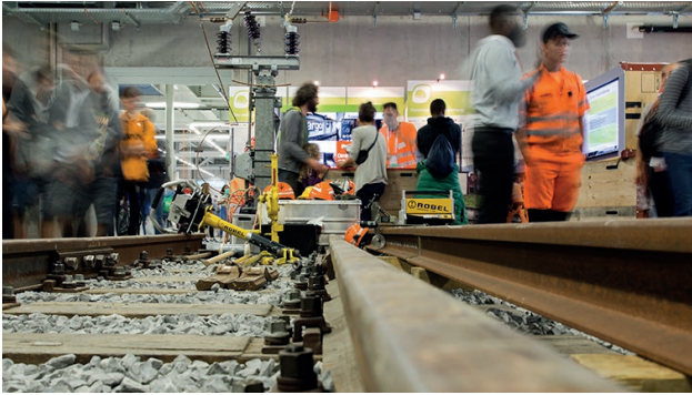
Die Gleisbauer brachten gleich ein ganzes Gleisstück samt Fundament mit.
