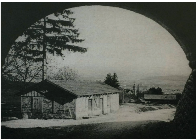
Zwei Baracken , im Vordergrund vielleicht eine Pinte, welche den Bauarbeitern des Weissensteintunnels zur Verfügung stand. Blick von der Bahnunterführung Oberdorf Station Richtung Süden. Fotos: Emanuel Saladin, 1908
