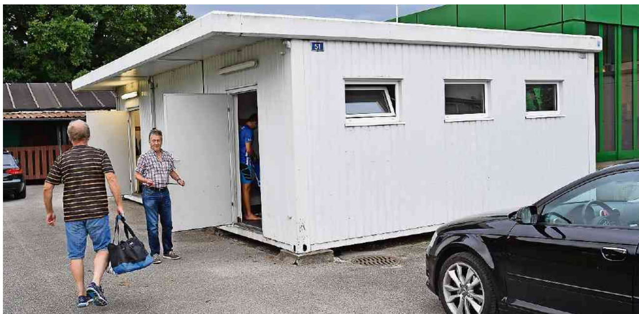
Die knapp 20 Jahre alten Garderobencontainer östlich der Stadthalle werden demnächst rückgebaut.
