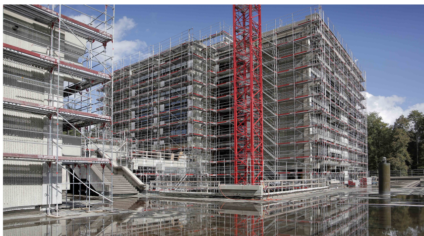
Die Aussenanierung des grossen Kanti-Schultrakts ist in vollem Gange. (Bild: ZVG)
