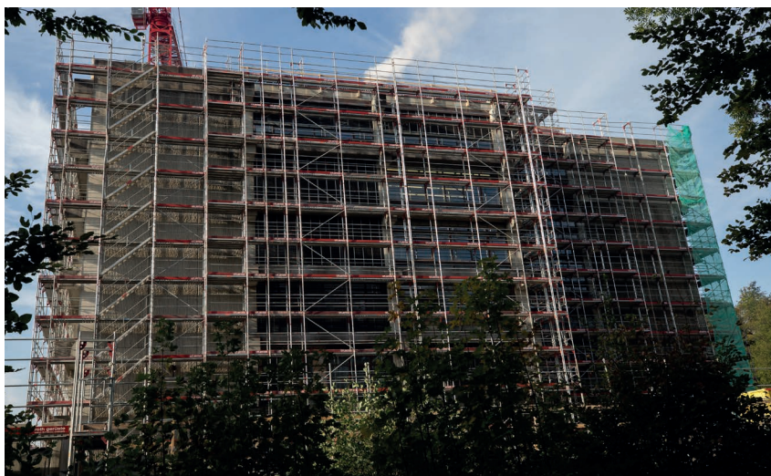
Die Fassade des Hauptgebäudes befindet sich mitten in der Sanierung.
