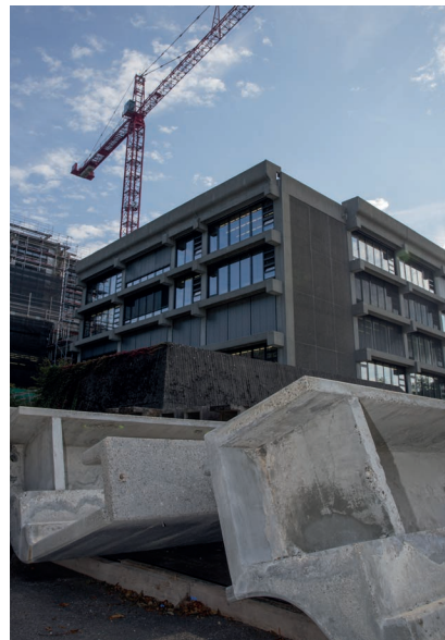
Im Hintergrund das Nebengebäude mit sanierter Aussenhülle und im Vordergrund liegen die unbearbeiteten Elemente des Hauptgebäudes.
