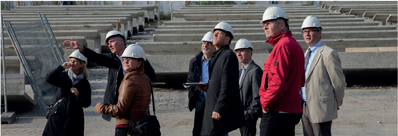
Gesamtprojektleiter David Brunner erklärt den Gästen den Ablauf der Arbeiten an den grossen Betonelementen.
