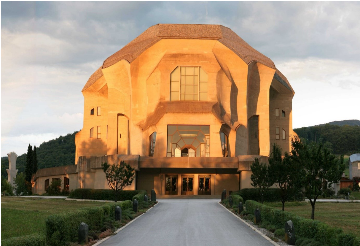
Das 1925 bis 1928 aus Beton erbaute heutige Goetheanum in Dornach ersetzte den abgebrannten Vorgängerbau von 1913. (Bild: zVg)
