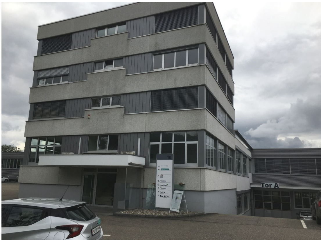
In einem Bürogebäude im Gewerbequartier von Oensingen hat der Verein den Gebetssaal und weitere Aufenthaltsräume eingerichtet. (Bild: ZRF)
