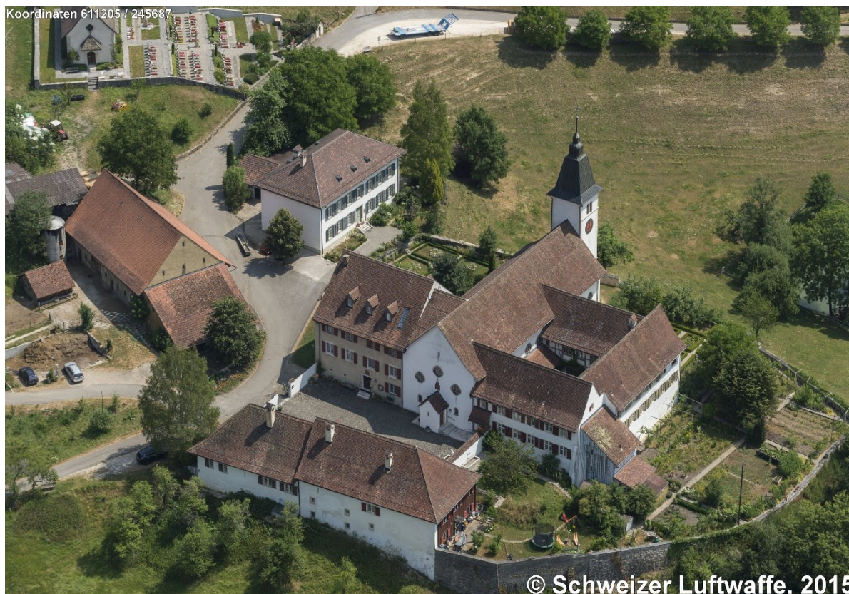
Das Kloster Beinwil in einer Luftaufnahme. Die Kirche gehört zur Kirchgemeinde Beinwil. Die angebauten sowie die gegenüberliegenden Gebäude und der Garten gehören zum Orthodoxen Kloster. Bild: VBS
