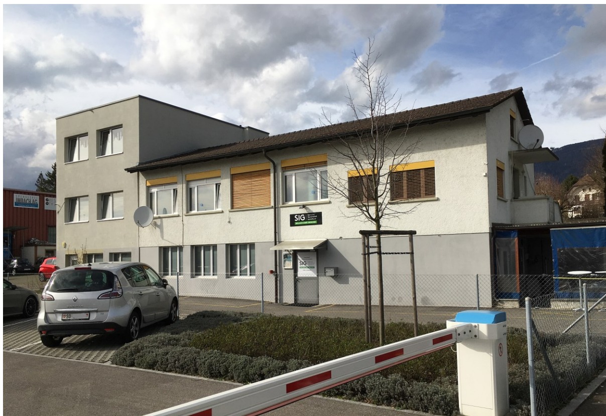
Das Gebäude des türkischen Moscheevereins in Bellach in einer Phase des Innenumbaus. (Bild: ZRF)
