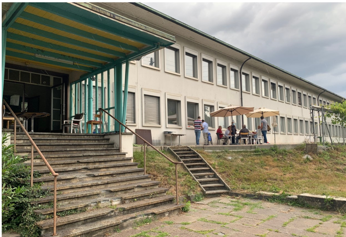
Im 1. Stock dieses Gebäudes im Gewerbegebiet ist die türkische Moschee untergebracht. (Bild: zVg)
