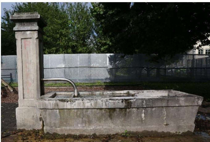
Abb. 3 Brunnen, bei dem der Konsum ab der Röhre verunmöglicht wurde, indem die Röhre bis knapp über die Wasseroberfläche verlängert wurde. Der Brunnen befindet sich bei einem Kinderspielplatz.
