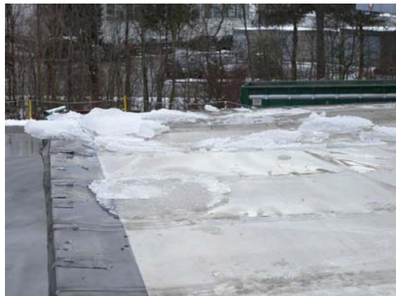
Eisschollen auf dem Dach des Sattelschleppers
