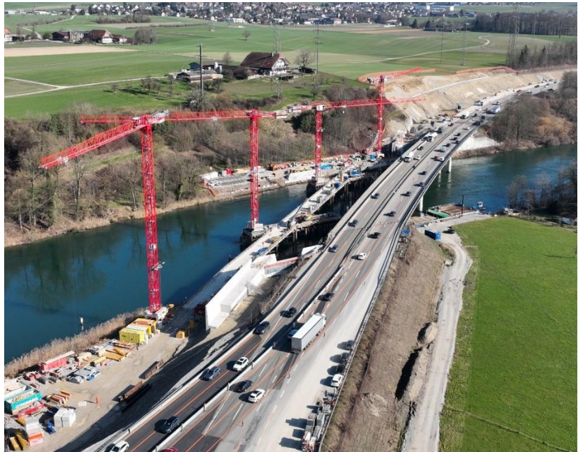
Neubau der Aarebrücke A1 im Bereich Wangen a. A.
