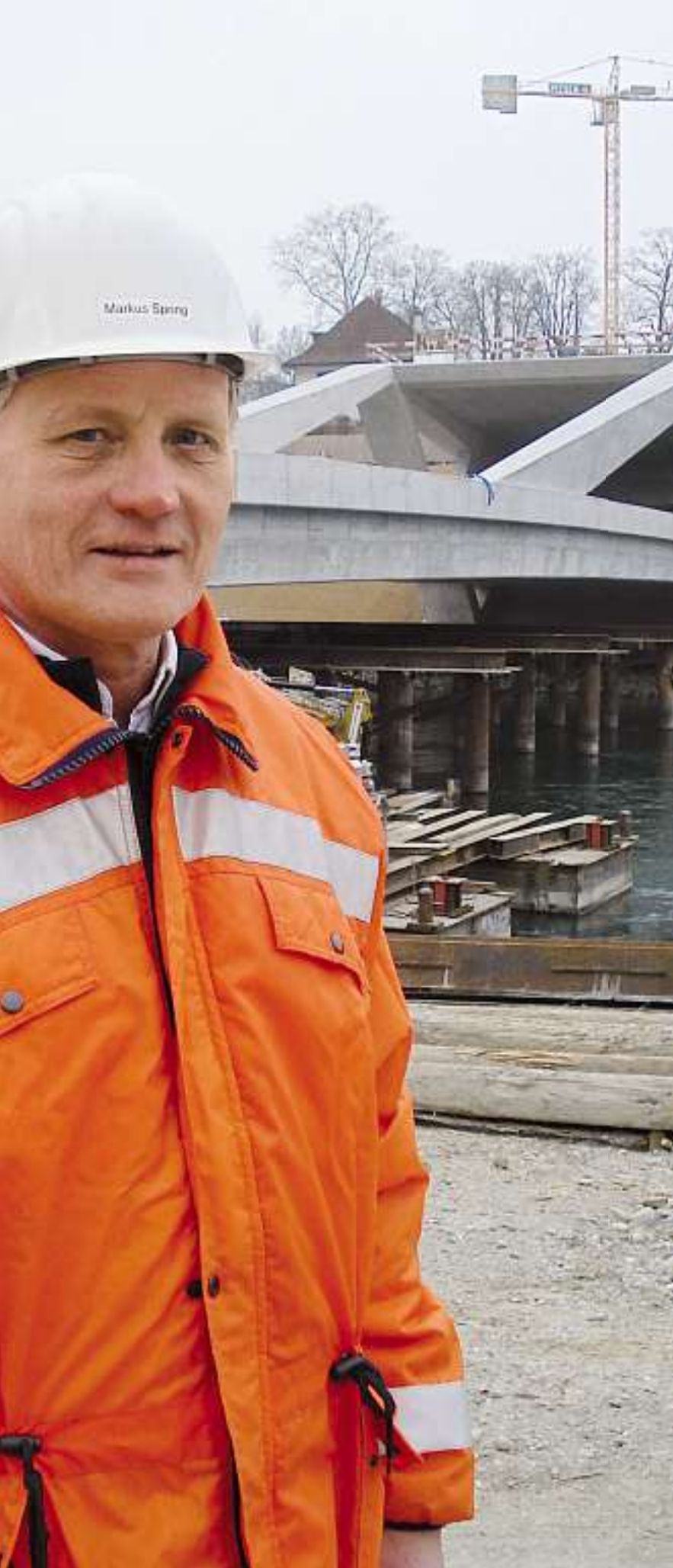
Der stellvertretende ERO-Gesamtprojektleiter Markus Spring vor der Aarebrücke, die den neuen Tunnel Hausmatt und das östliche Aareufer verbindet. lan
