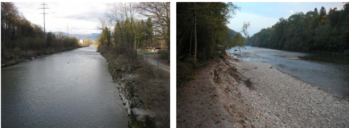
Bild 1: Bestehendes Gerinne (links) und mögliche Entwicklung nach der Gerinneaufweitung (rechts, Beispiel Emme im Winterseyschache oberhalb Burgdorf)
