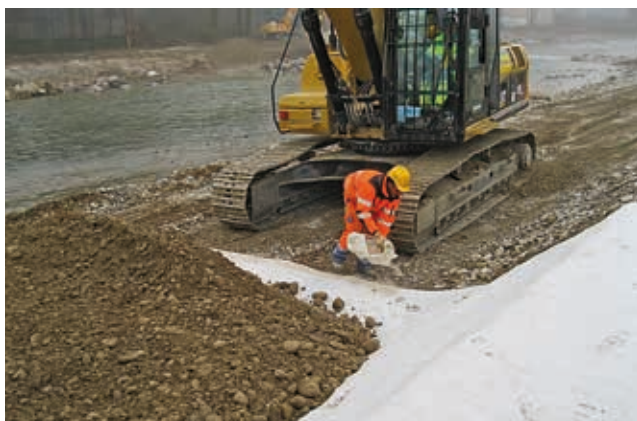
Ein neuer Damm entsteht.
