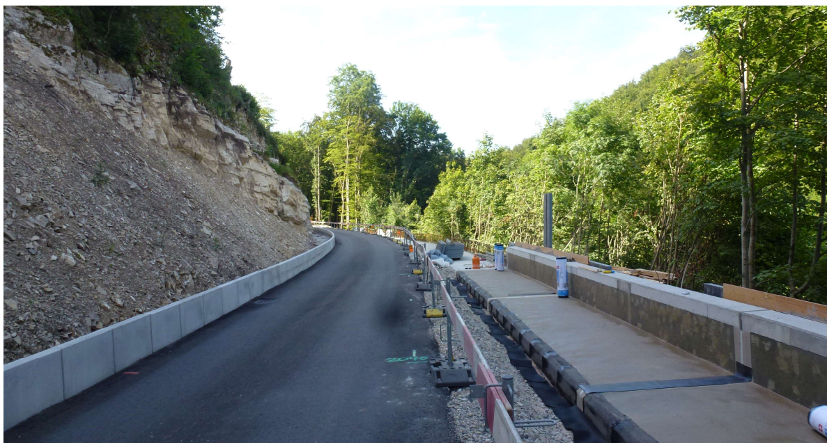
Talseitige Stützkonstruktion auf Mikropfählen im Abschnitt der Phase 1
