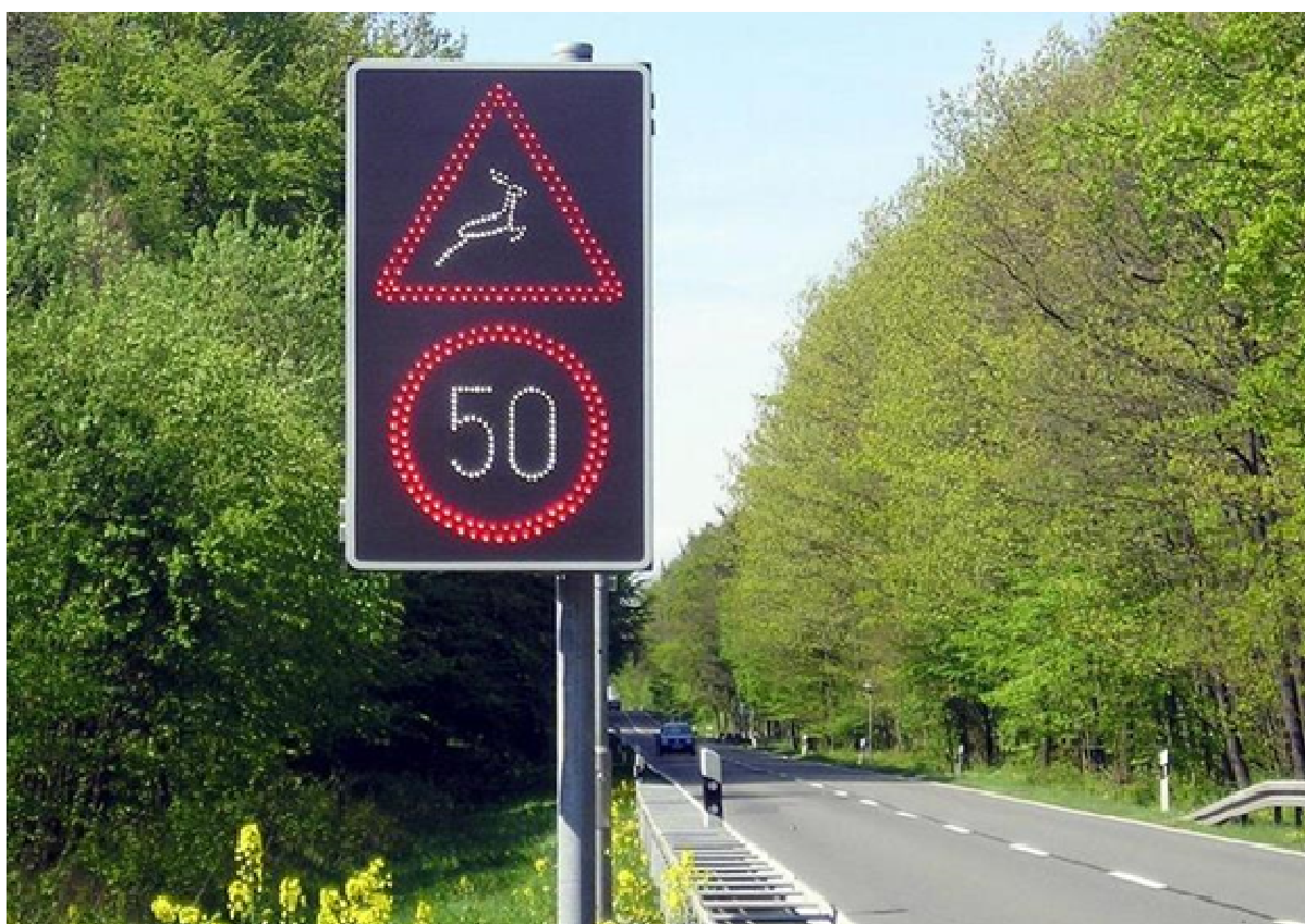
Bild: Signalisation einer Wildwarnanlage
