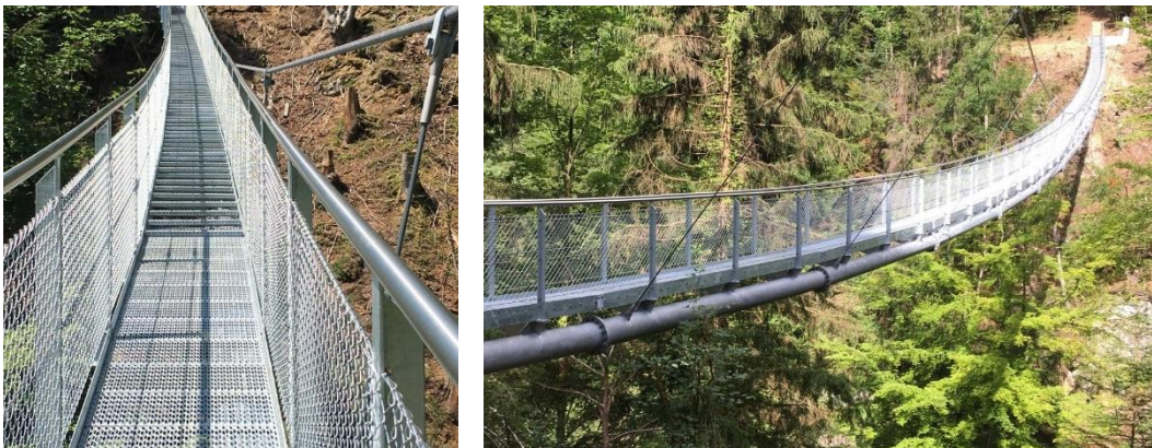
Abbildung 13: Seilbrücke Sundbach, Beatenberg (Breite 0.80m)
